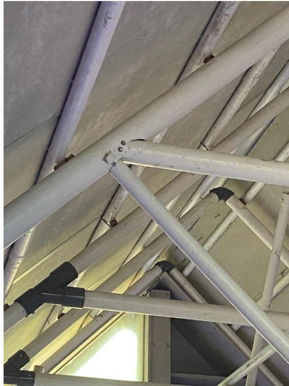
L-5 3. Cara Penyambungan Kuda-Kuda di Lapangan
