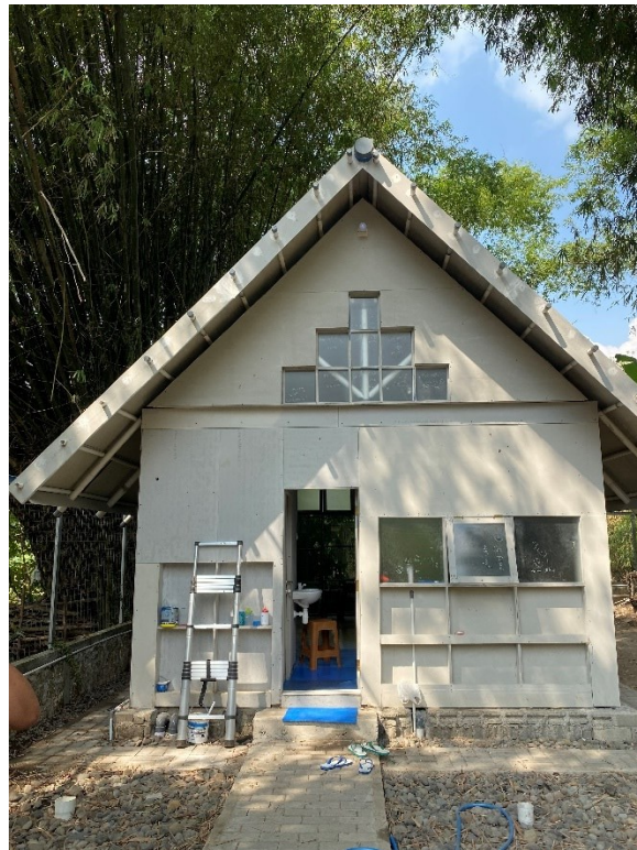
L-5 1. HUNTARA yang ada di lapangan
