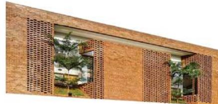
Fasad depan yang bersifat tertutup tetap membutuhkan pencahayaan dan penghawaan alami yang baik untuk ruang didalamnya. material eksterior bata merah yang unik dengan sifat solid yang menutup secara visual namun dengan susunan tertentu dapat memasukan cahaya maupun angin kedalam bangunan.
