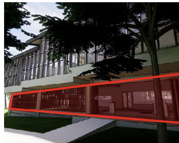
Gambar 3.39 Jendela Pivot sebagai Pengatur Intensitas Angin yang Masuk ke Dalam Gedung
