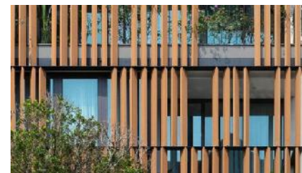
Gambar 2.40 Pengaplikasian WPC pada Fasad Bangunan Sumber: blog.indonetwork.co.id
