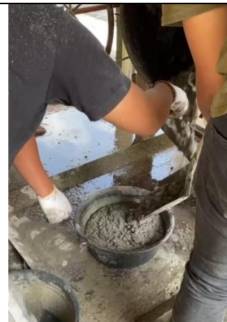
Penuangan Beton Segar
