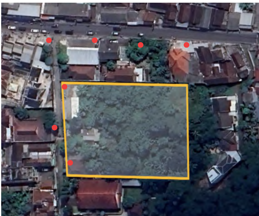
Gambar 2.11. Data lokasi infrastruktur Sumber : penulis, 2023
