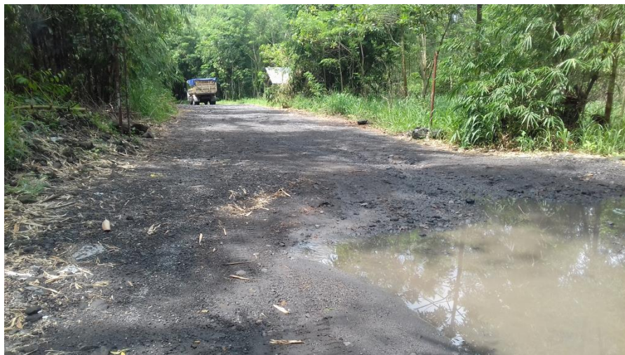
Gambar 1.1 Kondisi Ruas Jalur Evakuasi di Dusun Balong-Plosokerep
