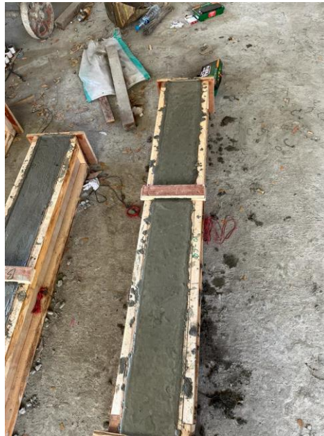
Gambar L-3. 4 Cetakan Telah Terisi Beton
