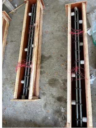
Gambar L-3. 1 Pemasangan Tulangan Pada Cetakan
