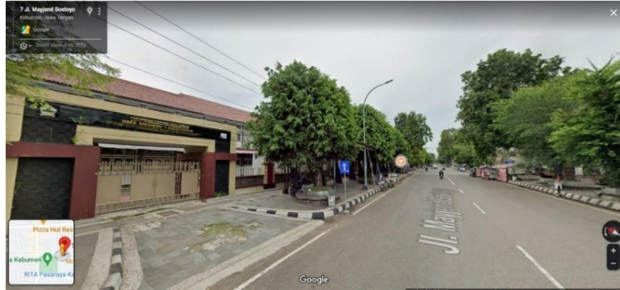
Gambar 5.25. Foto Jalan MJ Soetoyo Segmen G Sumber : Google Maps , 2022
