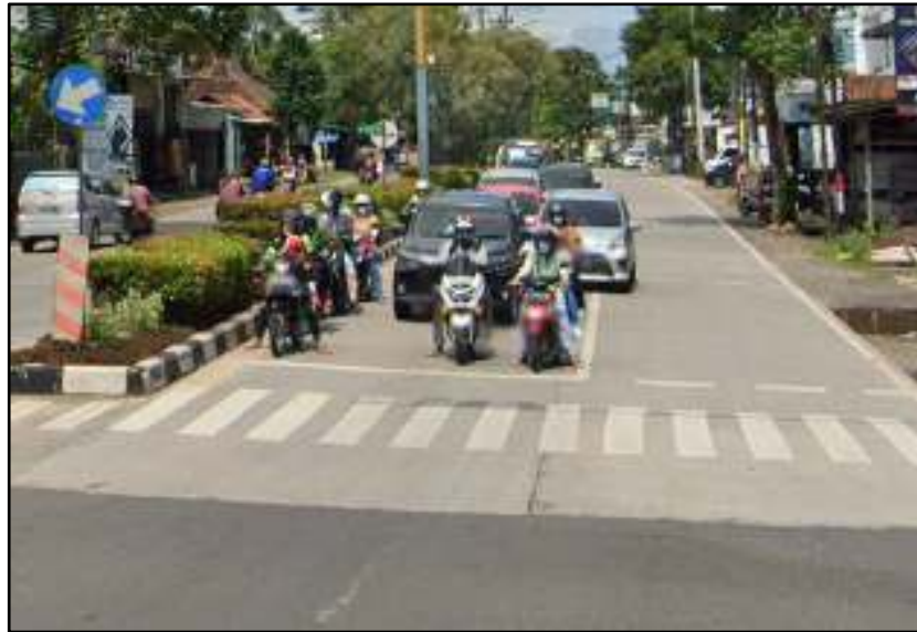
Gambar 4.48 Kondisi ruas Jalan Gerilya (Arah Simpang Tanjung)
