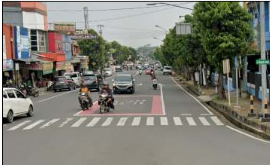
Gambar 4.65 Kondisi ruas Jalan Mayjend Sutoyo
