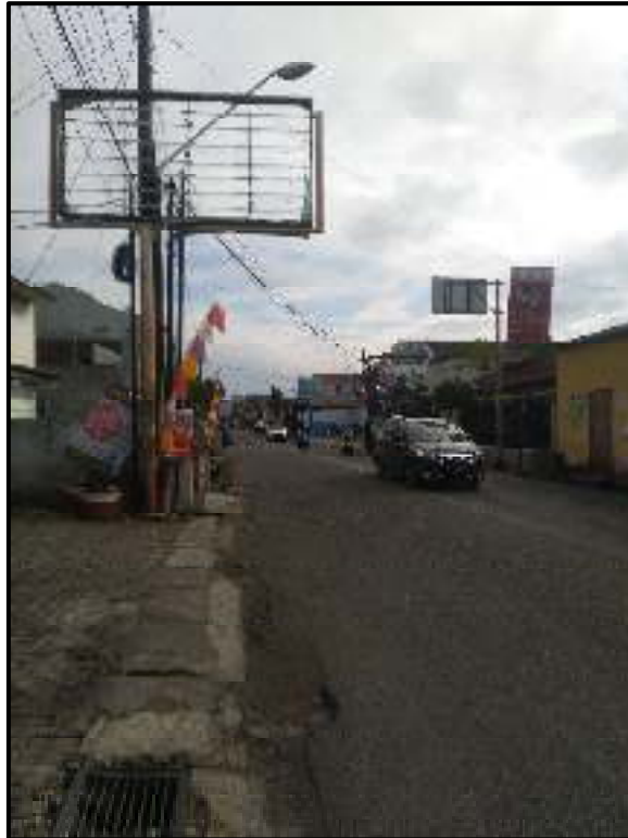
Gambar 4.19 Kondisi ruas Jalan Kolonel Sugiri
