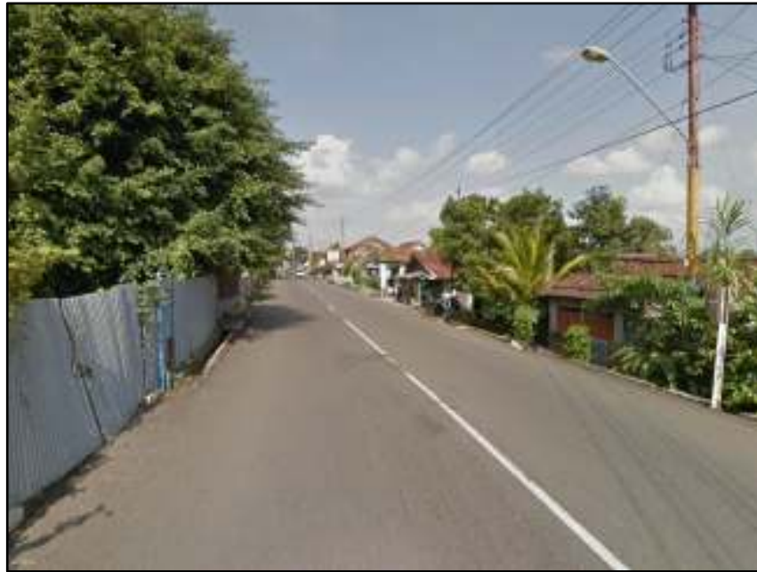
Gambar 4.15 Kondisi ruas Jalan Kolonel Sugiono
