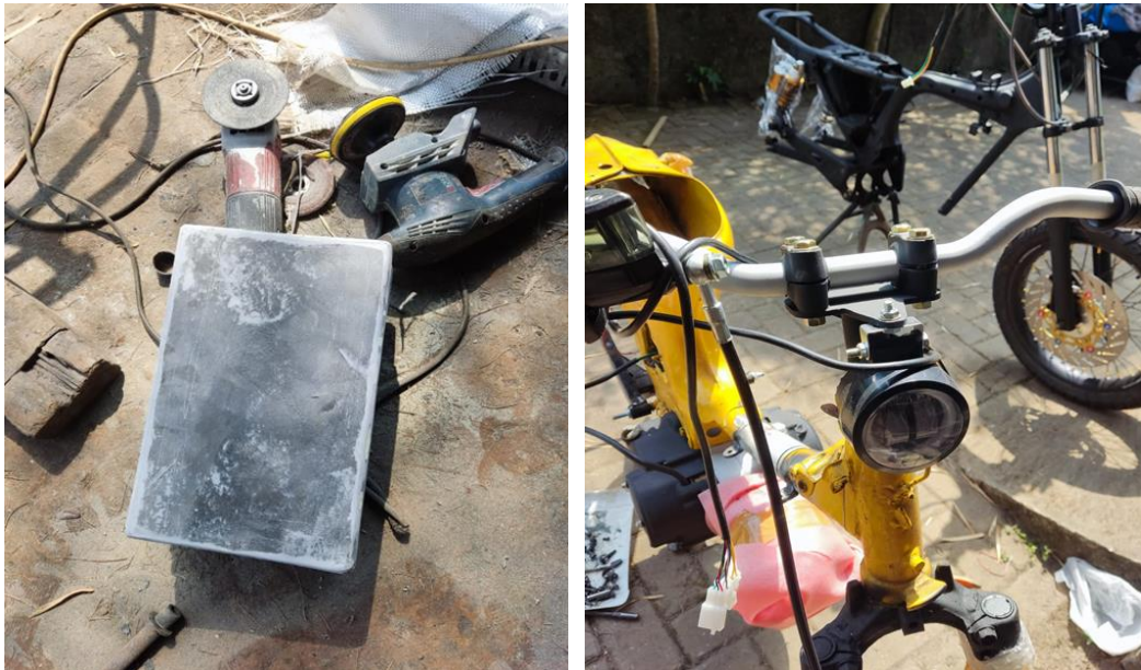
Gambar 4.3 Pemasangan Komponen Listrik
