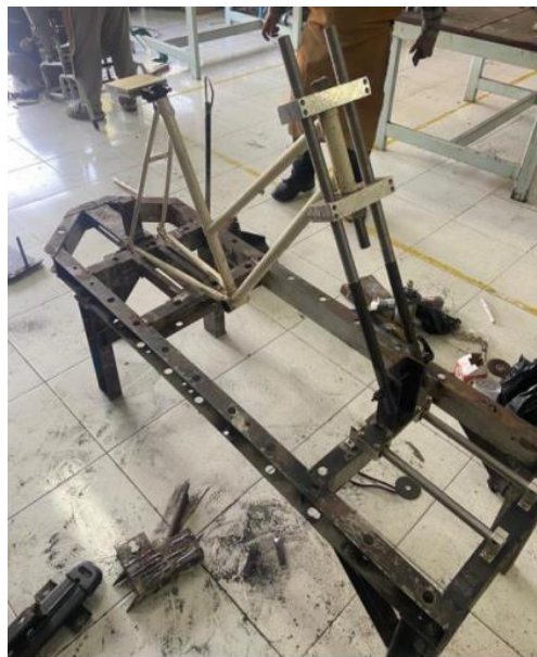
Gambar 4. 28 Perakitan alat uji
