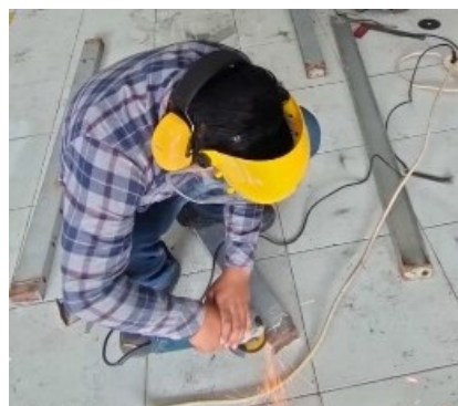
Gambar 4. 30 Proses Pembersihan Besi UNP
