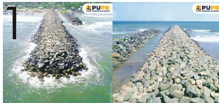
Gambar 2.13 Pembuatan Jeti menggunakan material batu armor Sumber : PUPR, 2021
