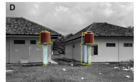
Lokasi Toren Air di Area perkantoran
