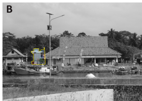
Lokasi Toren Air di Tempat Pelangan Ikan dan Pabrik Es
