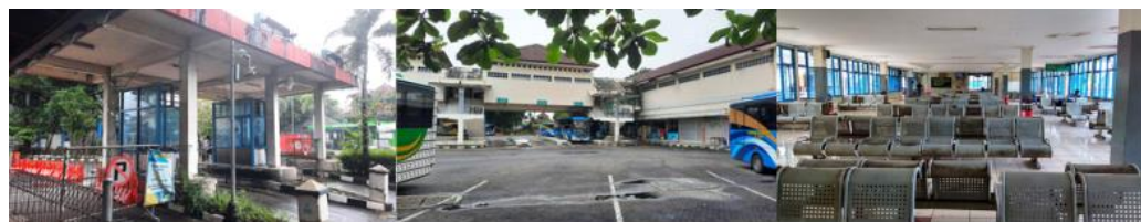
Gambar 25. Kondisi Eksisting Terminal Giwa
