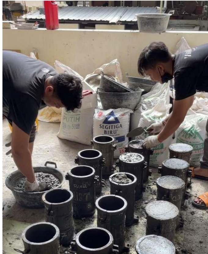
Gambar L-2.3 Proses Memasukkan Campuran Beton Ke Dalam Cetakan Silinder
