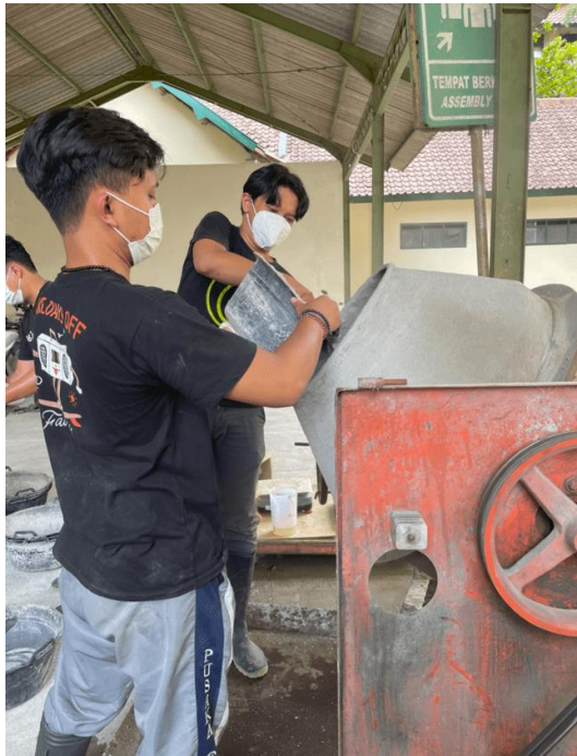
Gambar L-2.1 Proses Memasukkan Material Ke Dalam Mixer
