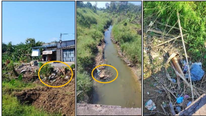
Gambar 4. 5 Kondisi Eksisting di Sekitar SKB 5 (Tengah)
