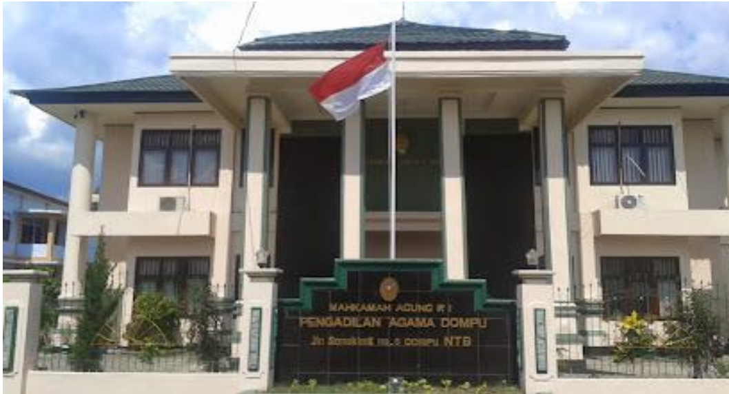
Gambar 1 Kantor Pengadilan Agama Dompu beralamat di Jalan Sonokling, Nomor 5, Kelurahan Bada, Kecamatan Dompu, Kabupaten Dompu, Nusa Tenggara Barat. Gambar foto diambil pada tanggal 15 September 2023
