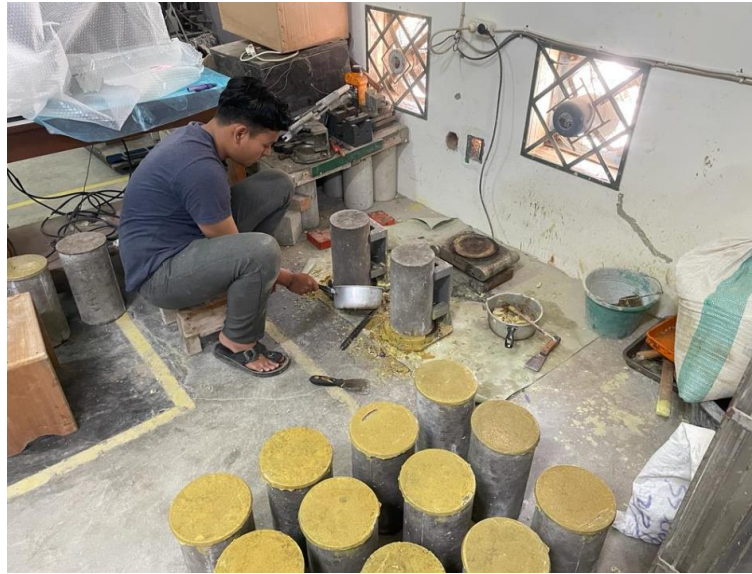
Gambar L-7.5 Proses Pembuatan Caping Beton
