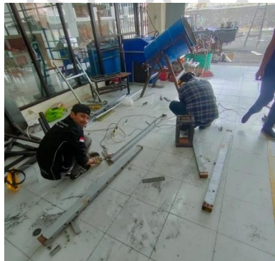
Gambar 4-19 Proses Pemotongan Besi UNP
