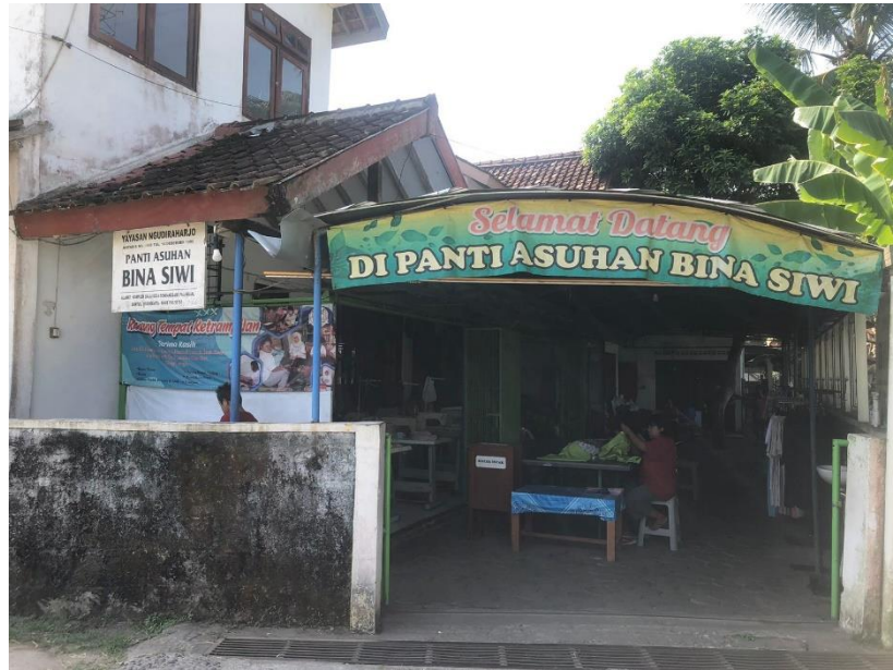
Gambar 1. Bangunan Panti Asuhan Bina Siwi
