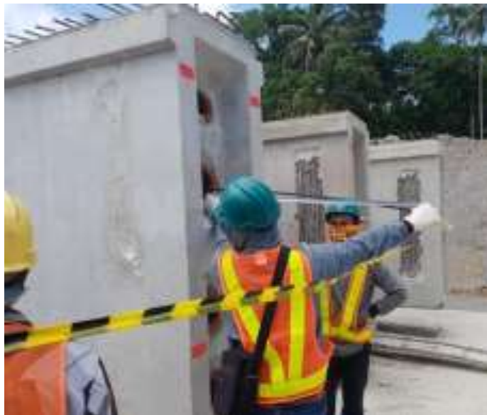
Gambar 4. Memasukan Kabel Baja & Pemasangan anchor block dan wedges
