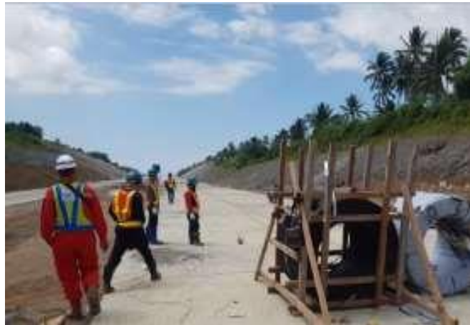
Gambar 5.17 Pemotongan Kabel Strand Sumber: PT.PP Persero (Tbk)
