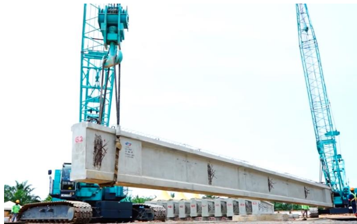
Gambar 5.27 Pengangkatan PCI Girder Dengan Mobile Crane Sumber: PT.PP Persero (Tbk)
