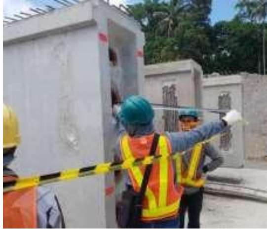
Gambar 5.19 Pemasangan anchor block dan wedges serta memasukkan kabel baja Sumber: PT.PP Persero (Tbk)
