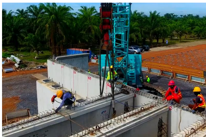
Gambar 5.28 Pemasangan Perkuatan Bracing Antar Girder Sumber: PT.PP Persero (Tbk)
