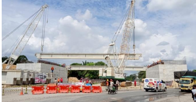
Gambar 3.3 Erection Girder Dengan Metode Mobile Crane Sumber: Google.com
