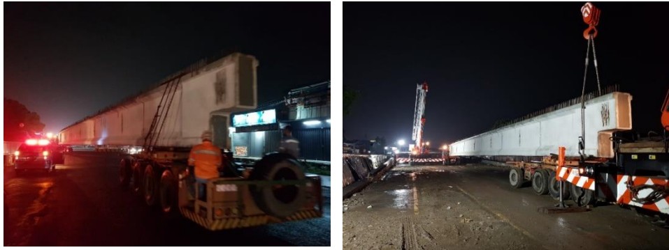
Gambar 5.11 Mobilisasi Segmental Girder dengan Boogie Truck di lapangan Sumber: (AP3I, 2019)
