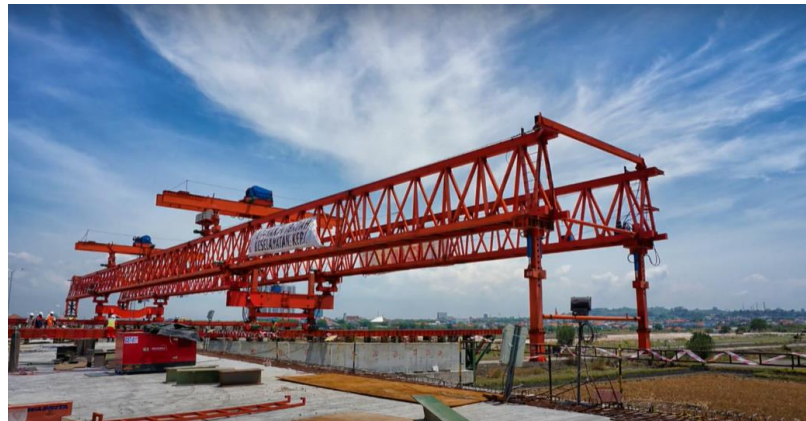
Gambar 3.4 Erection Girder Dengan Metode Launcher Girder Sumber: Google.com
