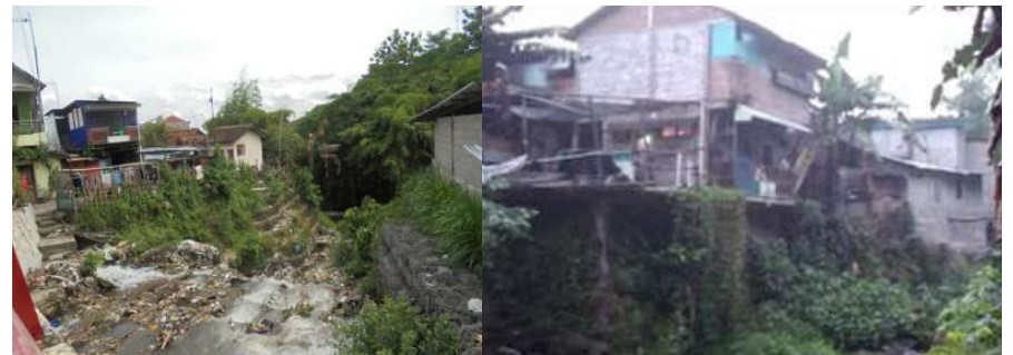
Gambar 2.9 Kondisi Permukiman Kumuh
