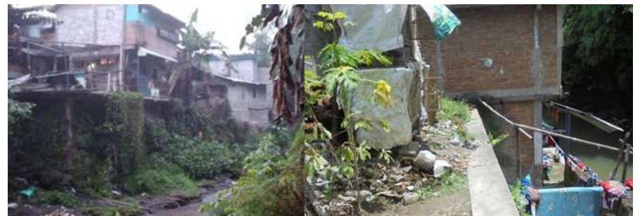
Gambar 2.11 Kondisi Permukiman Kumuh
