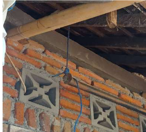
Gambar 3.5 Eksisting Rumah Cacing Sumber: Penulis, 2023
