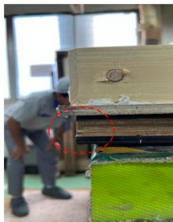
Gambar 5. 14 Kondisi Sisi Jig Moulder Sebelum Dilakukan Perbaikan
