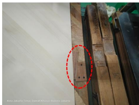
Gambar 5. 9 Kondisi Setelah Dilakukan Perbaikan
