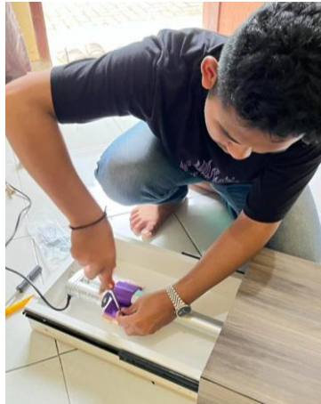
Gambar 4- 33 Pemasangan Lift TV
