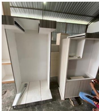
Gambar 4- 24 Proses Pemasangan HVL
