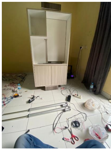
Gambar 4- 31 Pemasangan kabel aktuator linear
