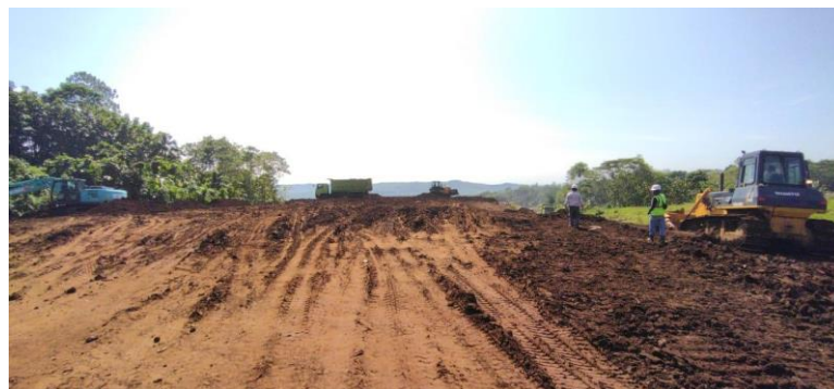
Gambar 5.23 Pengangkutan Tanah dari Quarry
