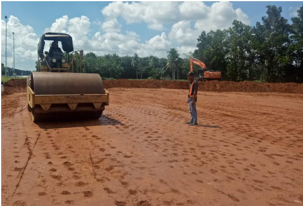
Gambar 3.2 Pemadatan Tanah dengan Vibro Roller
