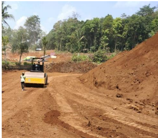
Gambar 5.14 Pemadatan Tanah
