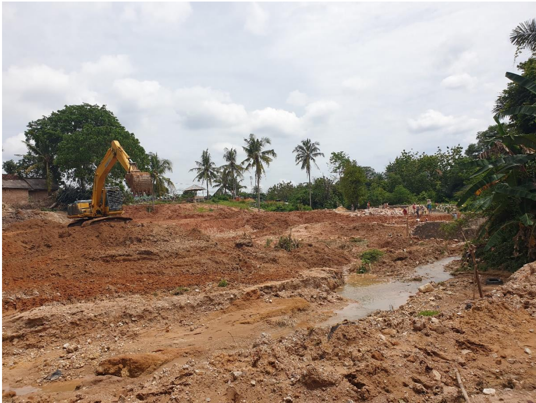
Gambar 3.1 Pelaksanaan Pekerjaan Penghamparan Tanah
