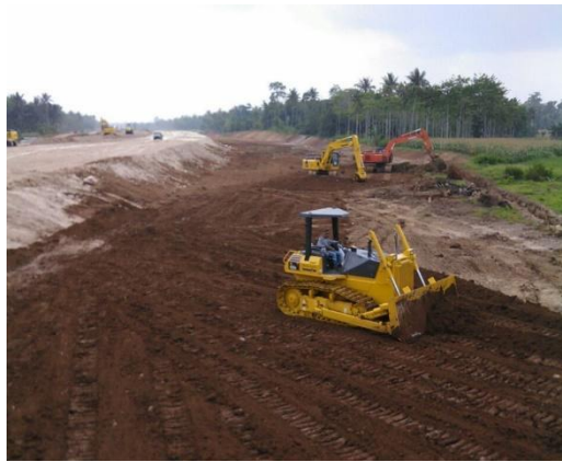
Gambar 5.24 Galian dan Penimbunan Tanah dari Quarry
