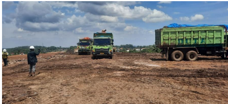
Gambar 5.22 Pengangkutan Tanah dari Quarry
