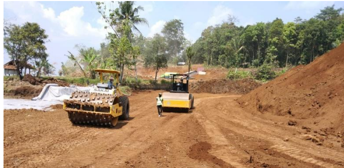
Gambar 5.25 Pemadatan Badan Jalan
