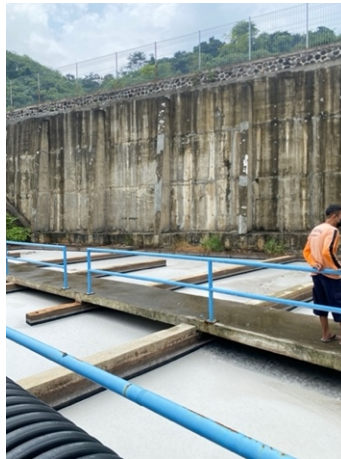
Gambar 3. 1. Lokasi IPAL TPA Piyungan
