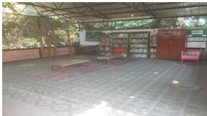
Gambar 4. 4 unit ABR IPAL Mendoiri
