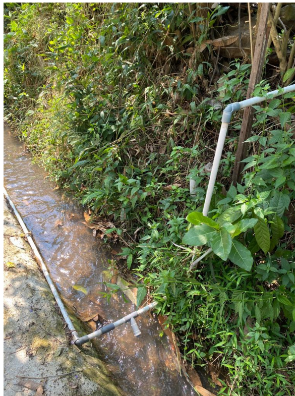
Gambar 3. 6 Instalasi Pipa Menuju Rumah Warga
