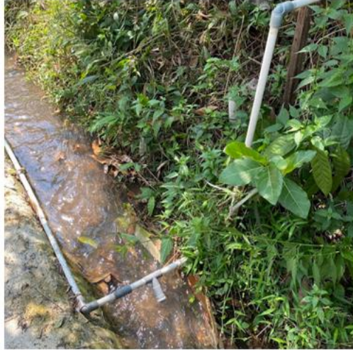
Gambar 4. 2 Keran Pembuka Saluran Pipa Biogas
