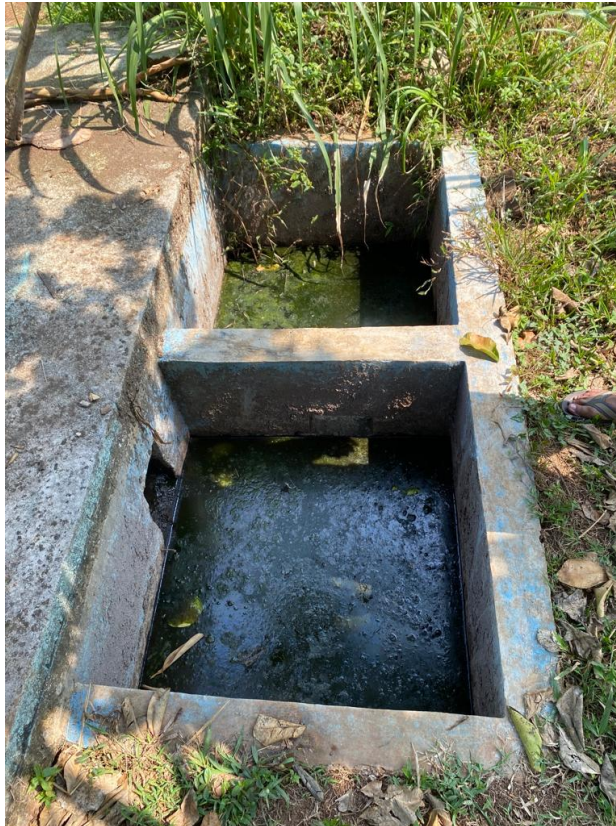
Gambar 3. 7 Outlet Biogas Desa Lau
