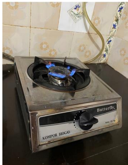
Gambar 4. 1 Nyala Api Kompor Biogas
