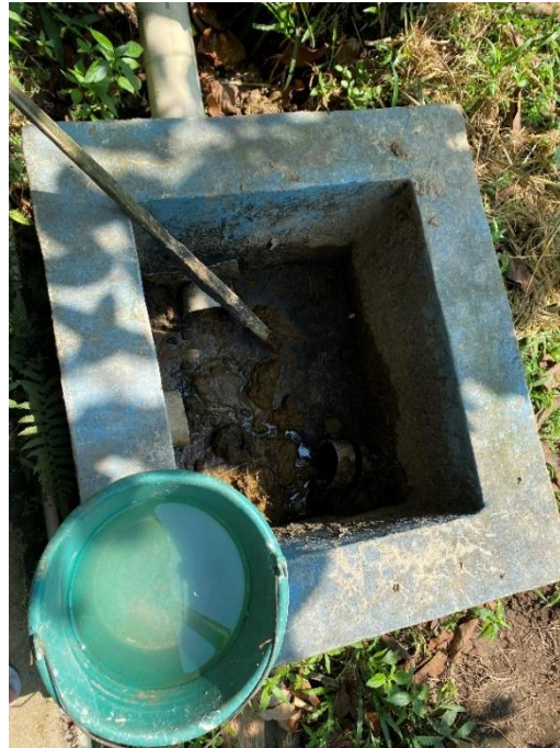
Gambar 3. 3 Inlet Biogas Desa Lau
