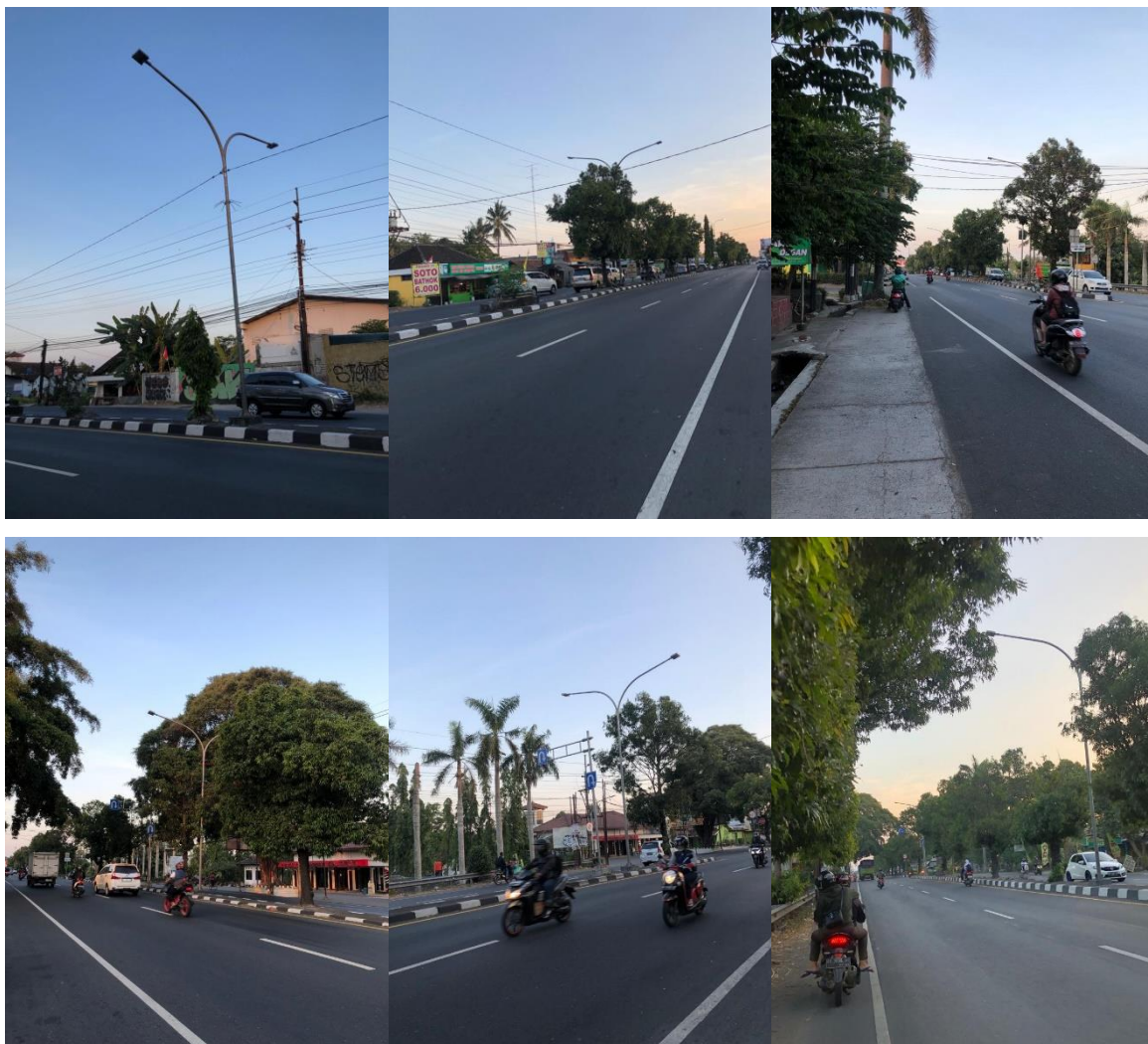
Gambar 5. 10 Perawatan Lampu Jalan
