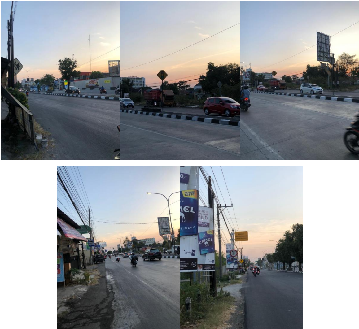
Gambar 5. 5 Lokasi Pengecatan Ulang Marka Jalan
