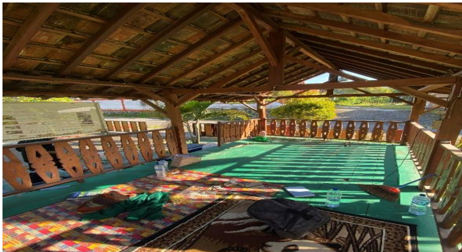
Gambar 5. 4 Kondisi Eksisting Pendopo (Tempat Peristirahatan)
