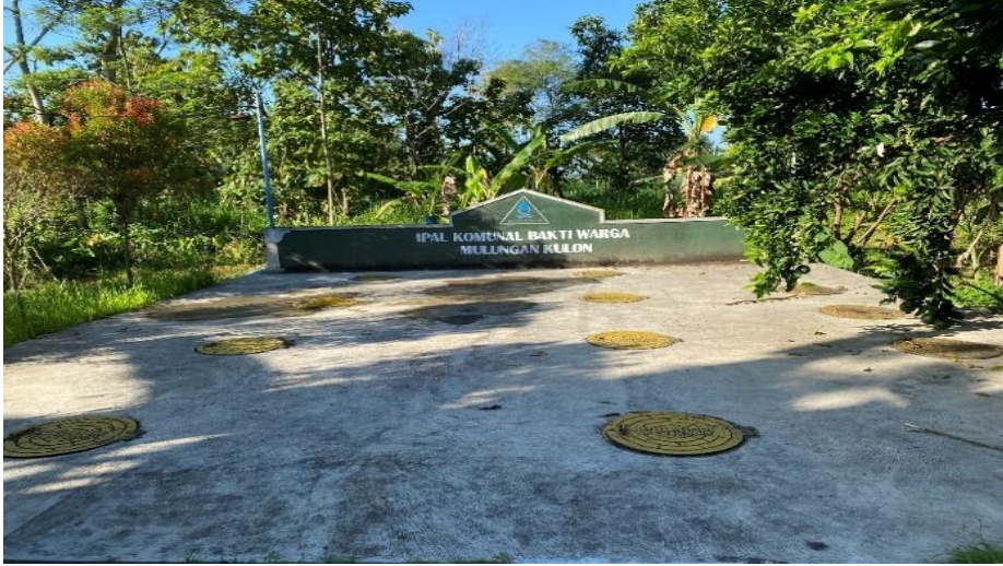
Gambar 5. 1 Kondisi Eksisting IPAL Bakti Warga
