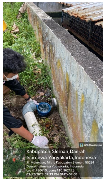
Gambar 4.4 Pengujian Debit Air Limbah Inlet dan Outlet
