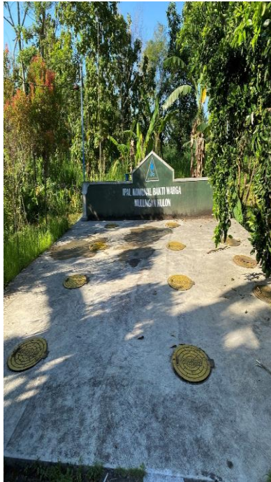
Gambar 4. 1 Kondisi Eksisting IPAL Bakti Warga (Unit ABR)
