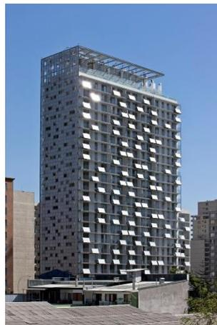
**Gambar 1** Fasad panel *photovoltaic* sebagai *shading devices*
