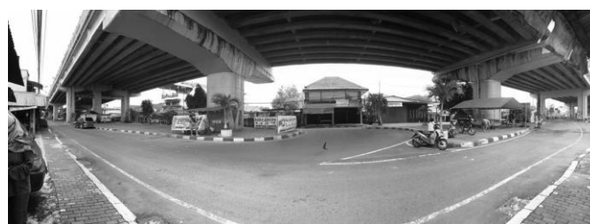
Gambar 5. Bentuk Eksisting Jembatan Layang Sumber: Penulis
