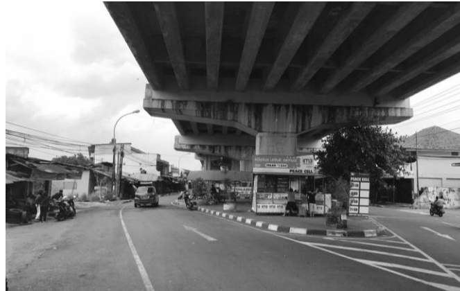
Gambar 6. Bentuk Eksisting Jembatan Layang Sumber: Penulis
