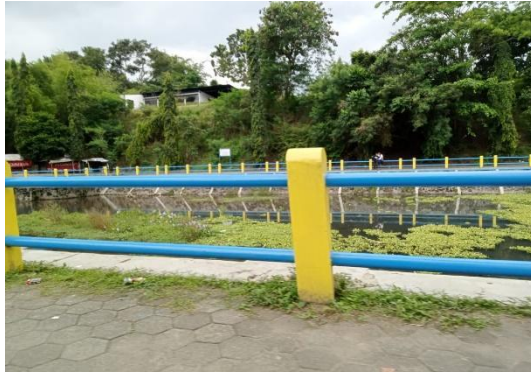
Gambar 16 Pagar Pembatas di Embung Tambakboyo Sumber: Penulis 2022
