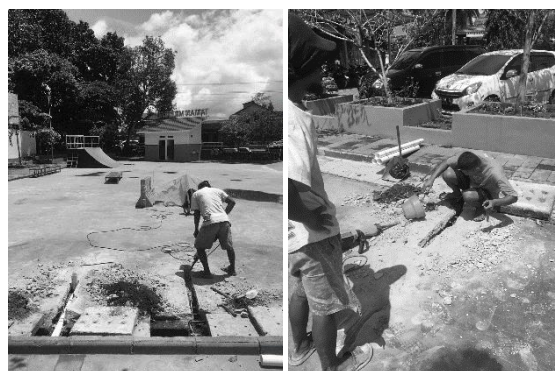
Gambar 11 Perbaikan Saluran Penyerapan Air Hujan Area Lapangan Sumber: Penulis, 2022
