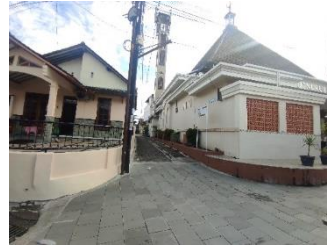
Gambar 11 Tampak sisi barat bersebelahan dengan gang Sumber: Penulis, 2023
