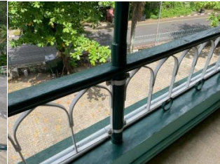
Gambar 10 Railing Bangunan Sumber : dokumentasi pribadi,2022
