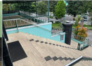
Gambar 9 Tangga Bangunan Sumber : dokumentasi pribadi,2022
