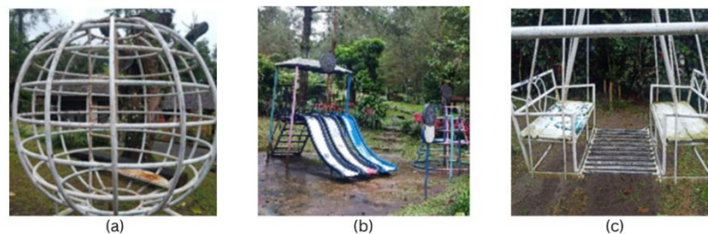
Gambar 7 (a) Permainan bola dunia dengan menggunakan material besi, (b) Permainan seluncuran dengan material fiber, (c) permainan ayunan dengan material besi pada kerangkanya dan kayu sebagai alas duduknya. Sumber : Dokumentasi pribadi, 2022
