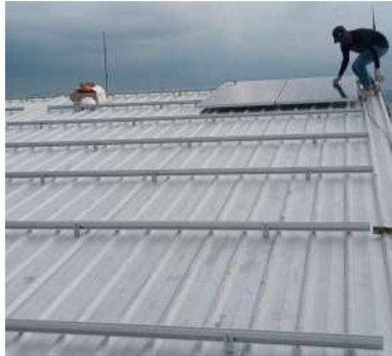
Gambar 4. 3 Pasang *Railing* dan PV Modul
