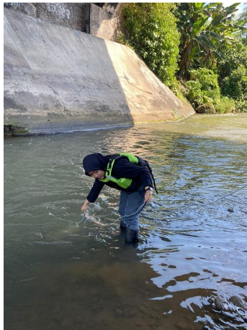
Titik ke 2 Jembatan Gondolayu
