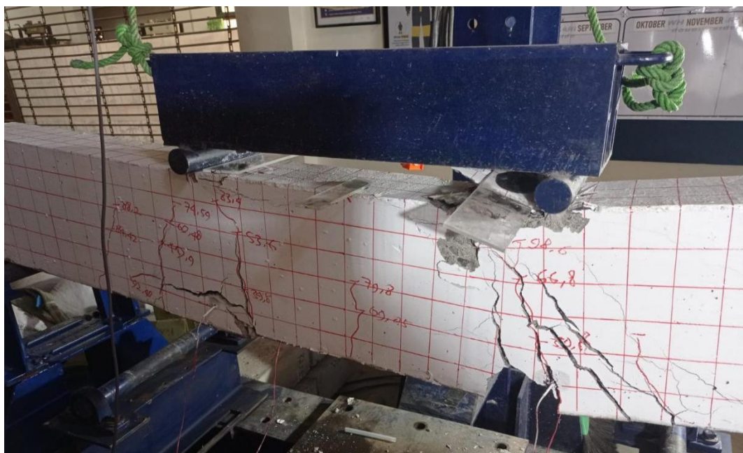
Gambar 5.16 Kerusakan Sampel Uji Balok Lewatan
