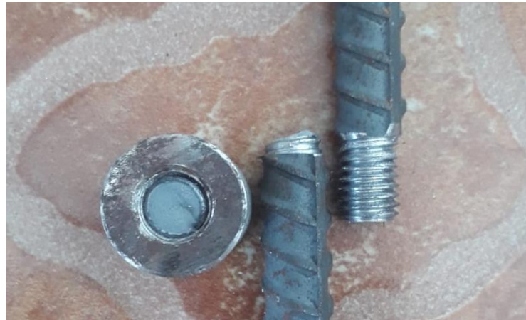
Gambar 5.5 Kerusakan Baja Tulangan dengan Sambungan
