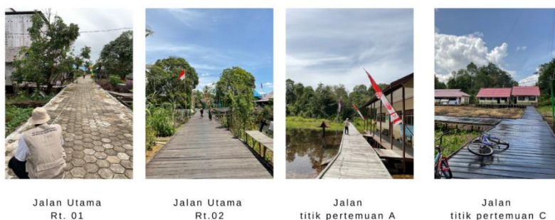
Gambar 12. Kondisi Jalan Desa Tampelas
