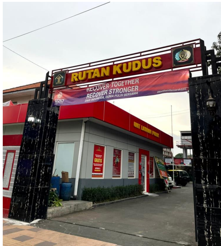
Kantor Rumah Tahanan Negara Kelas IIB Kudus Tampak Depan (Sumber: Dokumentasi Pribadi)
