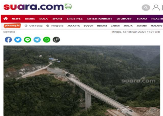
Gambar 3.32 Jembatan DK88 Kereta Cepat Jakarta-Bandung (KCJB)
