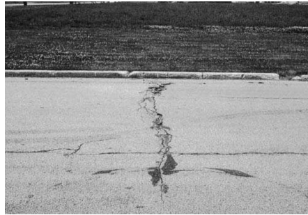
Gambar 3.5 Retak Memanjang dan Melintang
