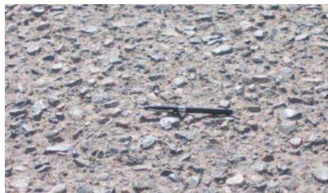
Gambar 3.18 Pelepasan Butir ( Weathering )
