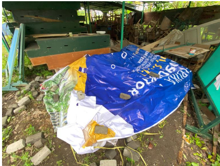
Gambar L-2. 8 Proses Penutupan Batako agar Tidak Merubah Kelembaban Batako
