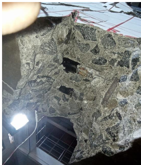
Gambar 5.22 Kondisi Tulangan Lewatan Setelah Pembongkaran
