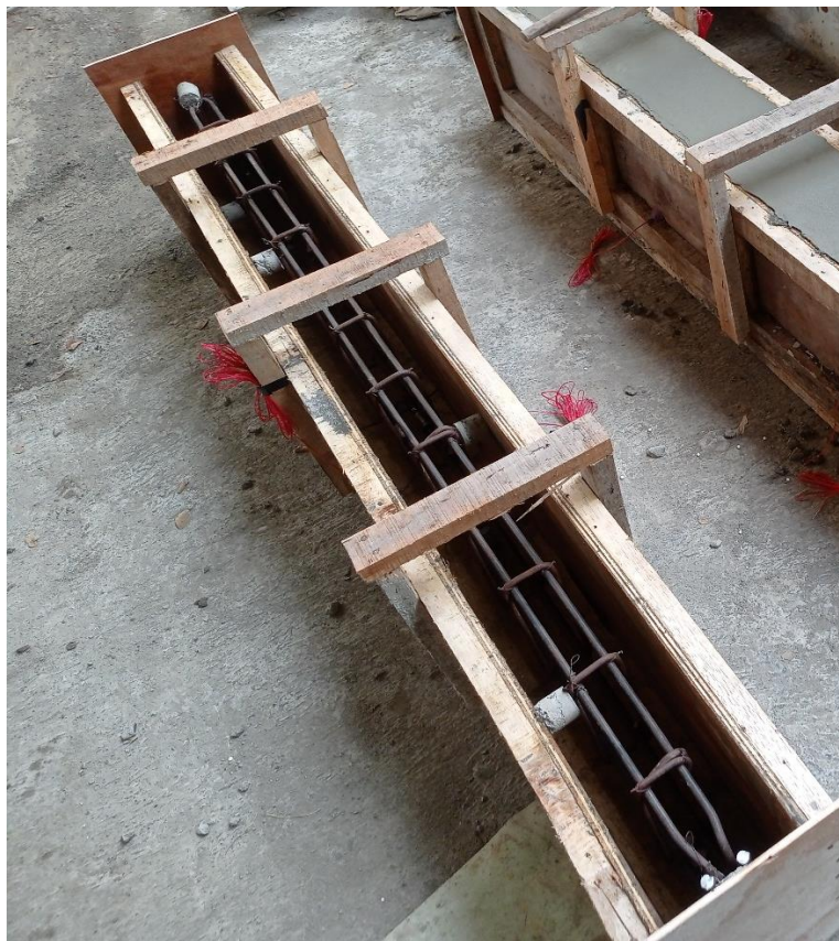
Gambar L-2.4 Pemasangan Tulangan ke Bekisting Serta Pemasangan Straingauge
