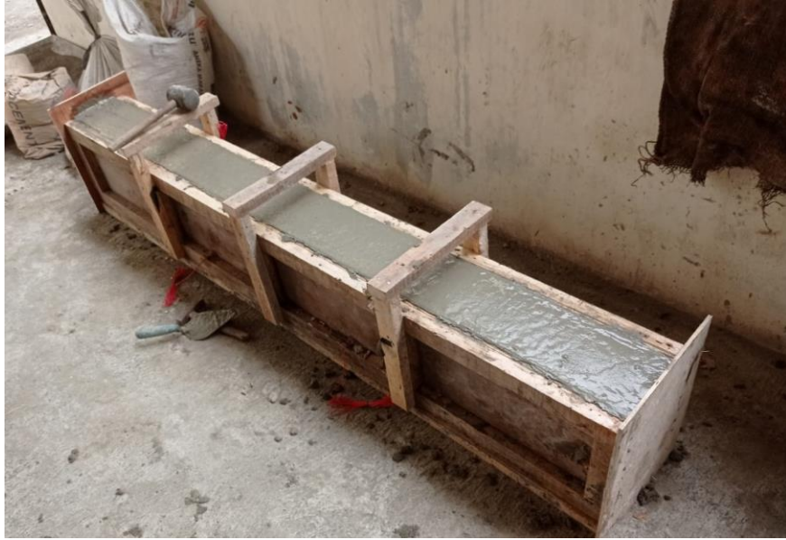
Gambar L-2.7 Proses Pengecoran Benda Uji Utama
