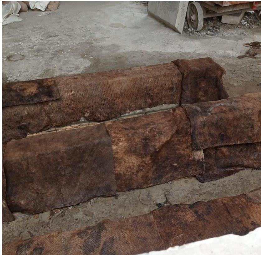
Gambar L-2.8 Proses Curing Menggunakan Karung Basah
