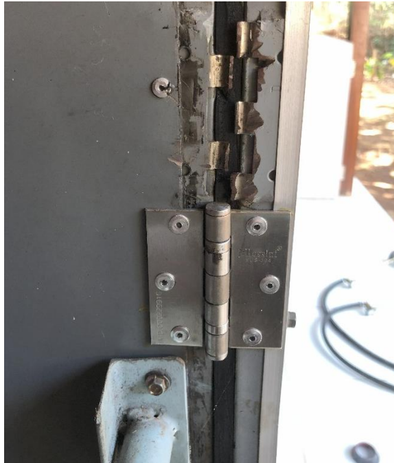
Gambar 4. 13 Engsel Pintu Mesin Pengering Setelah Diganti
