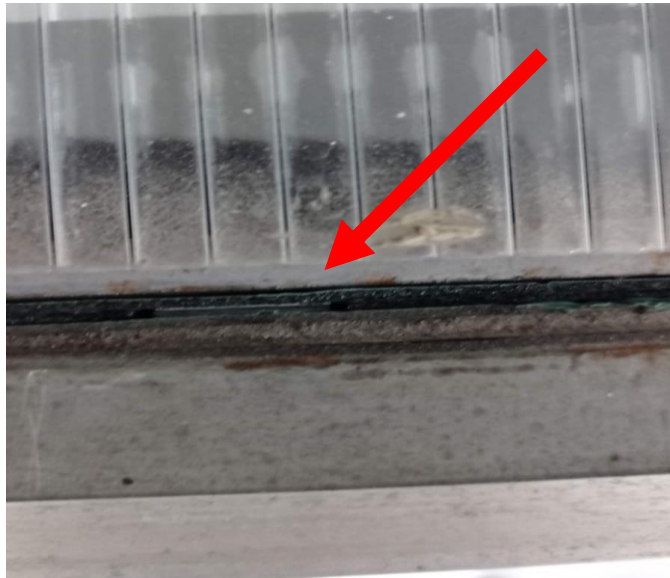
Gambar 4. 10 Double Tape Sebagai Seal
