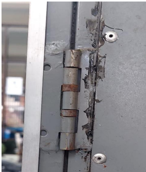
Gambar 4. 12 Engsel Pintu Mesin Pengering Sebelum Diganti
