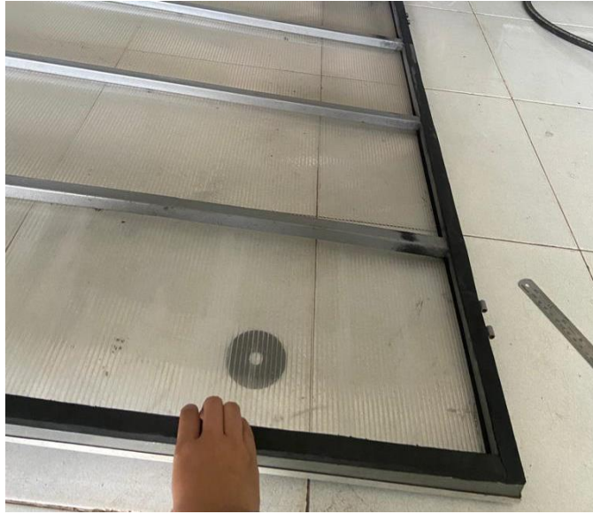
Gambar 4. 11 Pergantian Seal Pada Pintu Mesin Pengering
