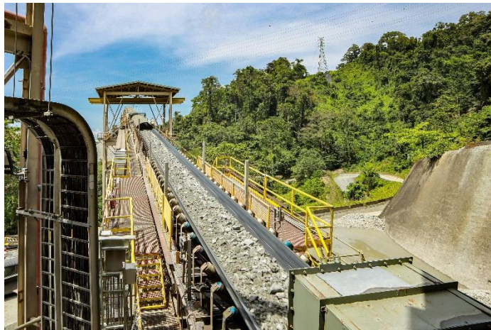
Gambar 5 Pengolahan Bijih Tembaga
