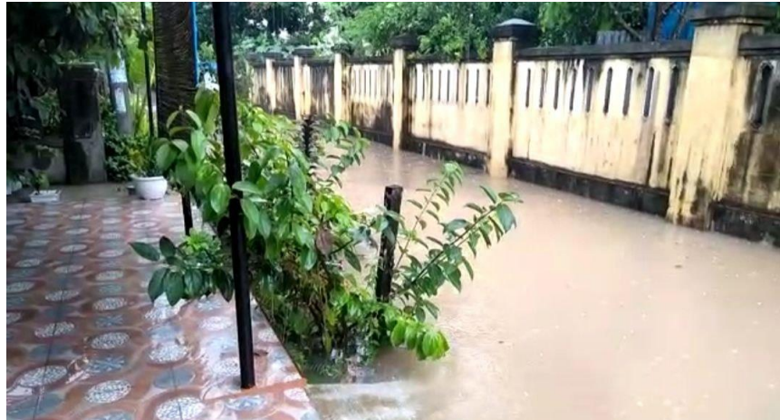
Gambar 5.4 Banjir yang Terjadi pada Saluran Drainase 11
